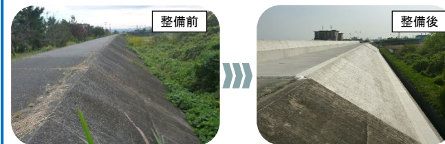
海岸堤防の耐震対策
