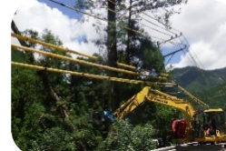
電線沿いの危険木の事前伐採
