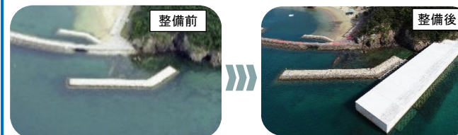
防波堤の整備
