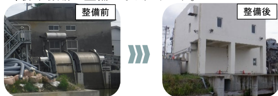
排水機場の耐震対策
