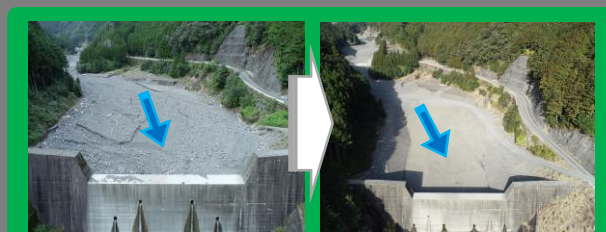
三戸川砂防堰堤（紀北町島原）
