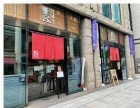
三重テラス外観
