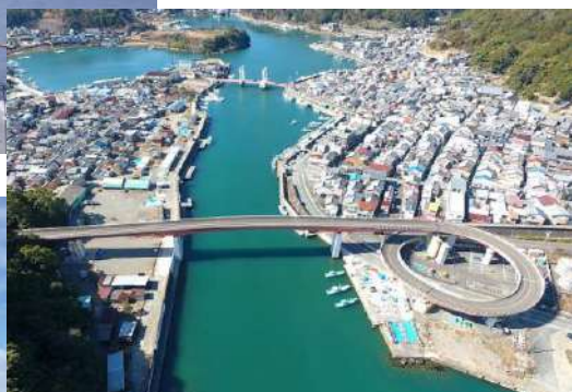
写真上 津松阪港 大口地区 岸壁(-7.5m) 施工状況
