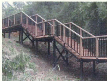
小瀬代の森（神奈川県） 使用材料：アルミ合金、再生木材 基 礎：ピンファウンデーション工法 多種多様な動植物が棲息している「小瀬代の森」に設置された木道。自然環境を第一に考え、基礎から構造材に至るまで耐久性に優れた木道になっています。
