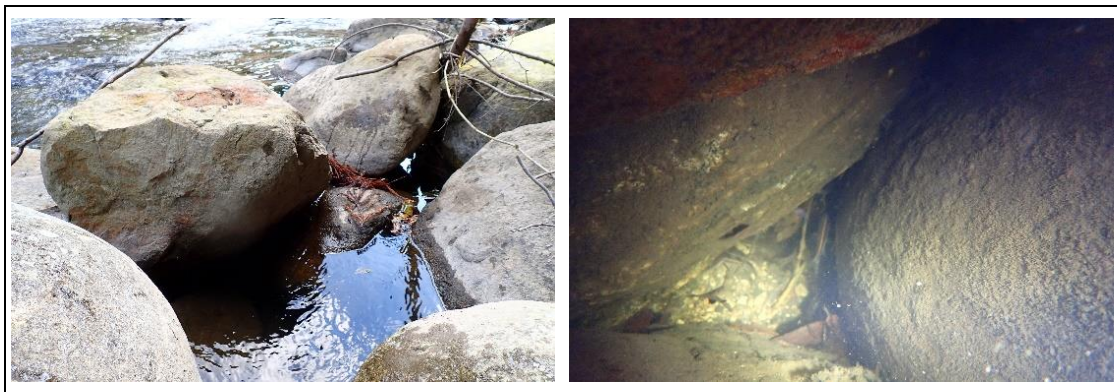
図 5.2.2 横穴の確認例（工事着手後、令和3年11月25日）
