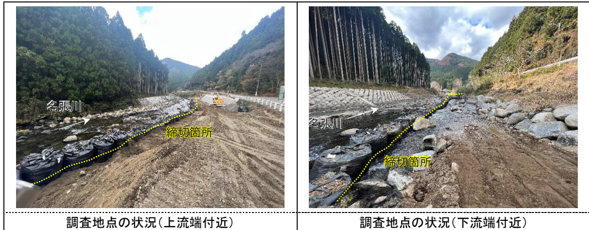
図 5.2.1 調査の実施状況（工事着手後、令和3年11月25日）
