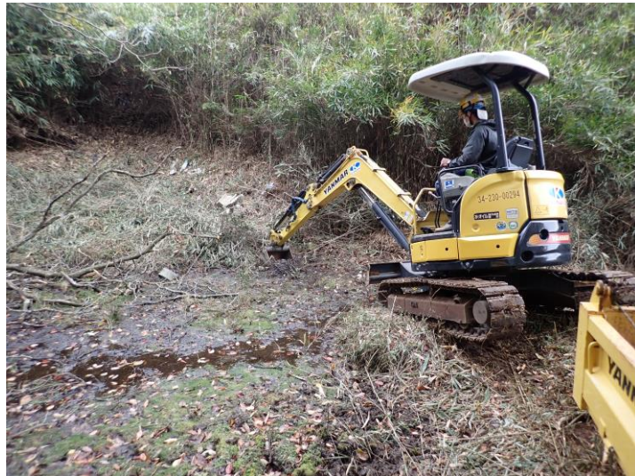
写真 4-14 池の掘削作業（令和 3 年 12 月 2 日 池・湿地③）
