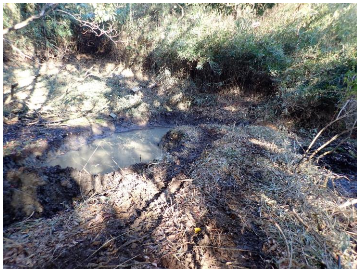
写真 4-15 池の掘削作業後（令和 3 年 12 月 2 日 池・湿地③）
