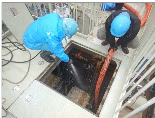
槽内清掃状況
