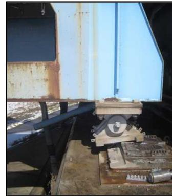
A1支承（可動）：上部構造の移動に伴いローラーから脱落
