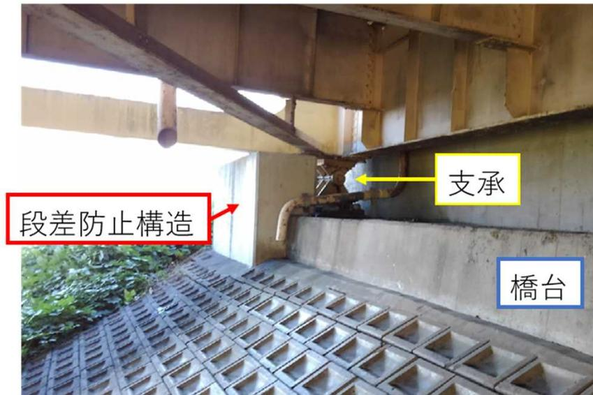
主桁下面の支承前面に設置した例
