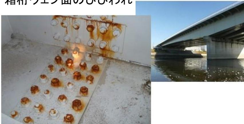
箱桁内のボルト部の腐食
