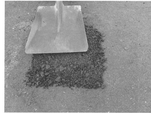
写真-4.2.9 スコップによる締固め状況
