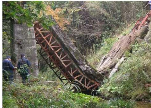
写真1 老朽化が原因で落橋した国内事例
