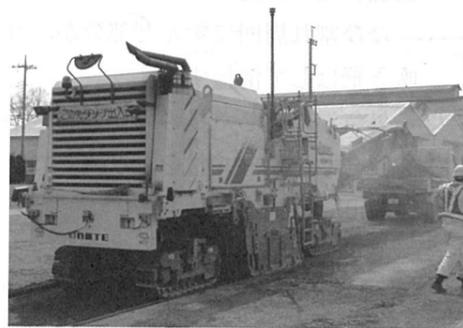
写真-4.2.13 路面切削機による切削状況
