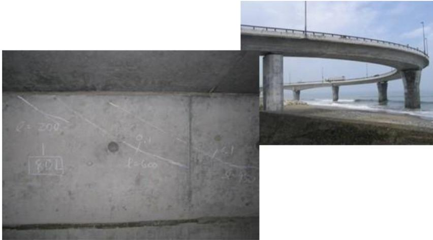
箱桁ウェブ面のひびわれ
