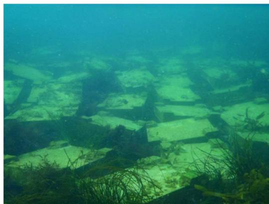
図1. コンクリート板を用いて造成したアワビ放流漁場
