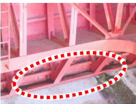
放流ゲートの発錆状況
