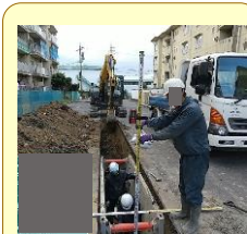
下水道接続工事
