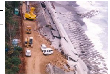
井田地区海岸平成9（1997）年被災状況
