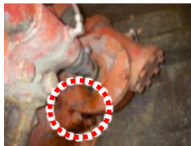
低水放流設備の漏油状況
