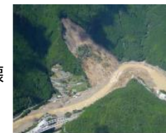
深層崩壊発生直後 (五條市清水地区)
