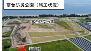
香良洲高台防災公園・避難路(津市)
