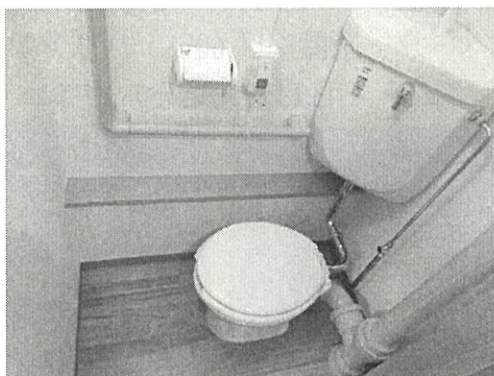
県営住宅における 高齢者仕様の整備事例（便器の洋式化等）
