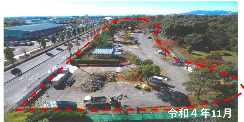
Park-PFI ロードサイドエリア（森公園）施工状況
