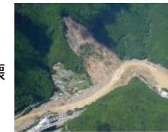
深層崩壊発生直後 (五條市清水地区)
