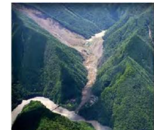
河道閉塞発生直後 (五條市大塔町赤谷地区)
