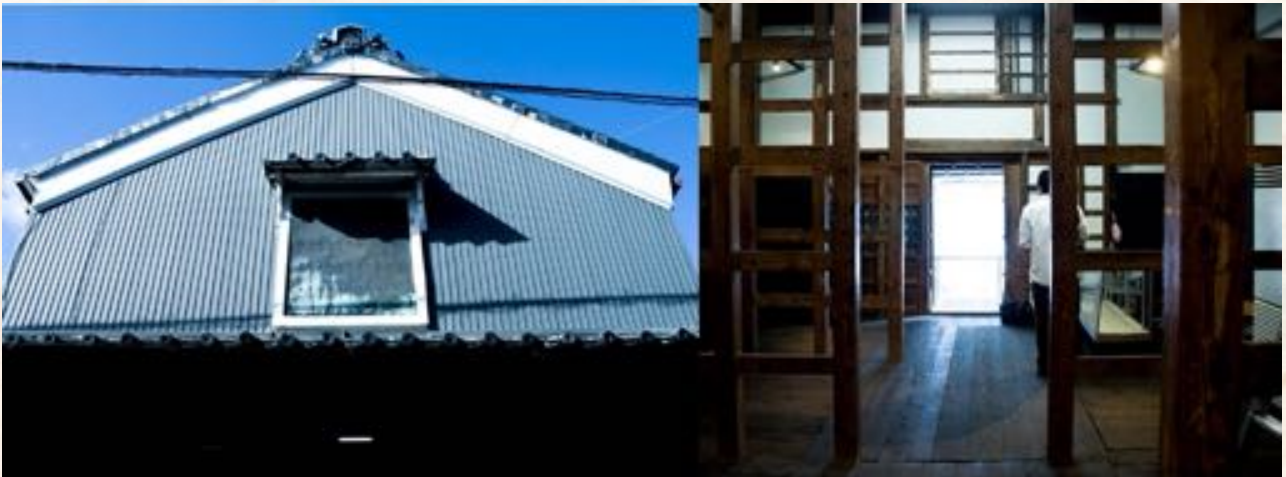
左から 蔵の外観、リノベーション中の内装
