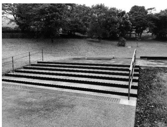
熊野古道センター中央階段修繕
