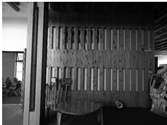
熊野古道センター空調機器修繕
