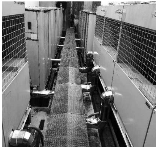
熊野古道センター空調機器修繕
