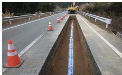
送水管布設替工事の施工例
