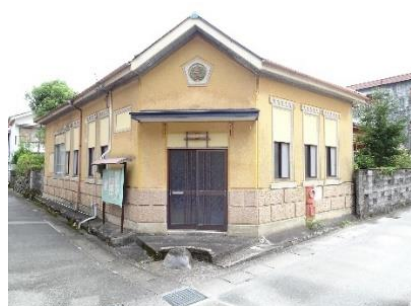
旧吉津郵便局舎（北東から）
