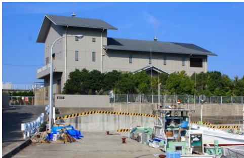
漁業集落排水処理施設
