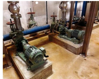
設備の整備、更新（ろ過原水ポンプ）
