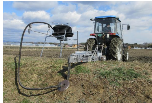
本暗渠を施工する様子
