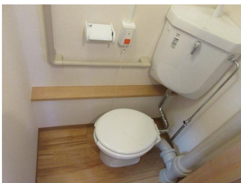
県営住宅における 高齢者仕様の整備事例(便器の洋式化等)
