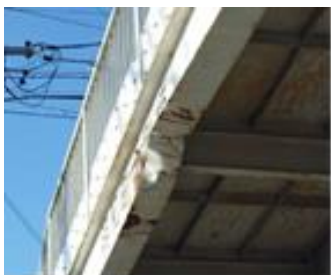
主桁階段部の腐食
