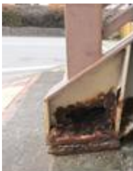
主桁階段部の腐食
