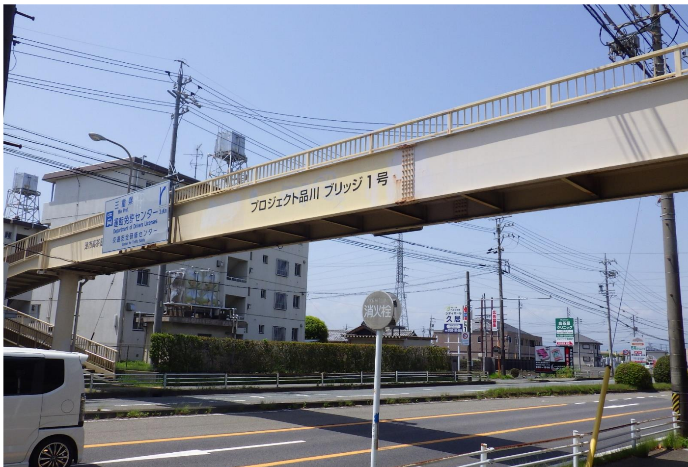
①高茶屋歩道橋（プロジェクト品川ブリッジ1号）
