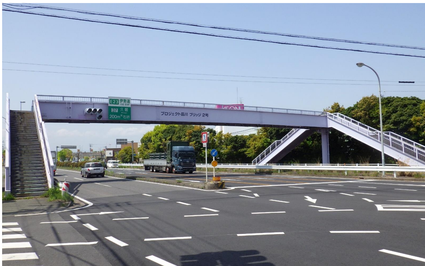
②インター横歩道橋（プロジェクト品川ブリッジ2号）
