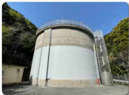
調整池の耐震補強
