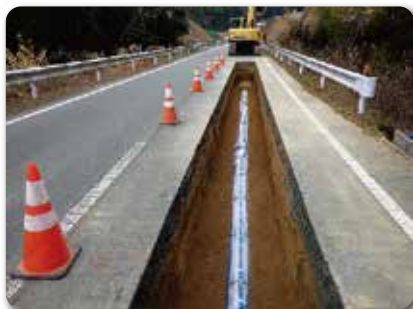
耐震管への布設替え
