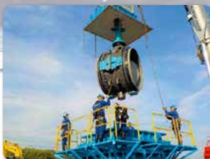
制水弁取替工事の施工状況
