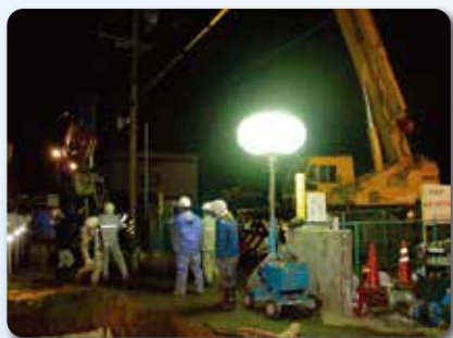
夜間の漏水復旧作業
