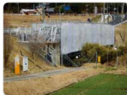
塗装塗替中の水管橋
