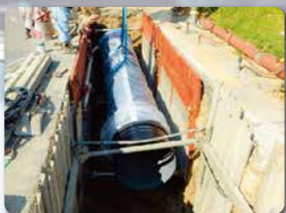
配水管布設替工事の施工状況
