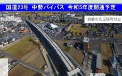
国道23号中勢バイパス整備箇所
