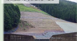
治山施設による山地災害の復旧
