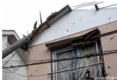
被倒塌的电线杆砸坏的房子
