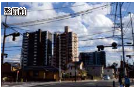
電線類の地中化
