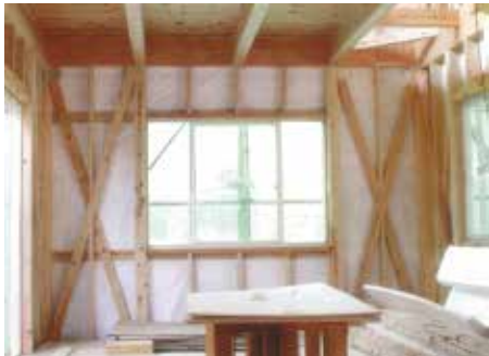
木造住宅の耐震改修
