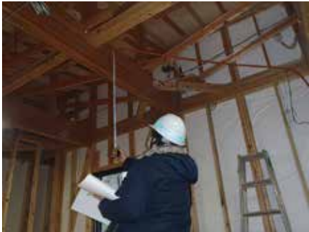
建築基準法による中間検査
