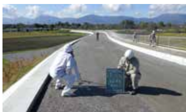
工事検査状況
