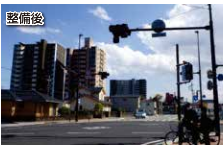
(都) 松阪公園大口線(松阪市)における電線類の地中化
