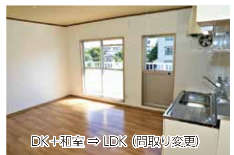
住戸内改修工事
