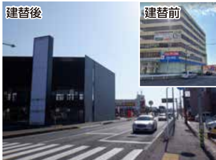
避難路沿道建築物の耐震化
