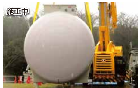
北勢中央公園(四日市市、菟野町、いなべ市)における老朽化対策(浄化槽の交換)
