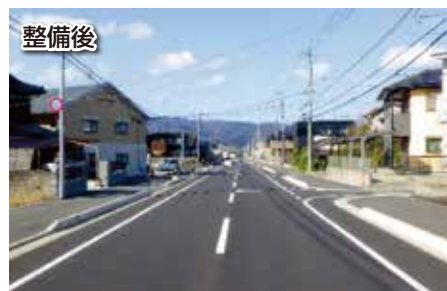
(都) 服部橋新都市線(伊賀市)における街路整備
