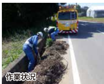
側溝清掃・倒木処理
