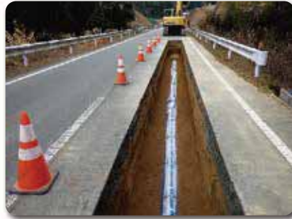
耐震管への布設替え
