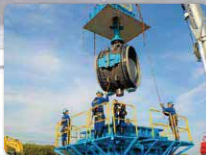
制水弁取替工事の施工状況
