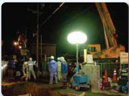
夜間の漏水復旧作業
