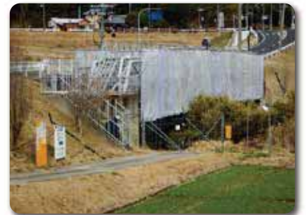
塗装塗替中の水管橋
