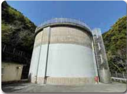
調整池の耐震補強
