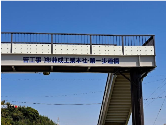
かいげちよう 貝家町歩道橋 「管工事 (株)兼成工業本社・第一歩道橋」 (四日市市)
