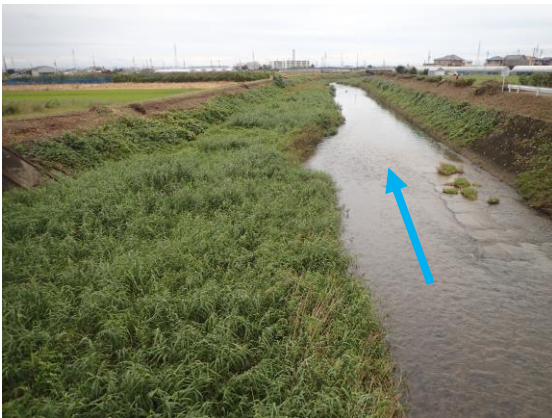
【外城田川】 堆積土砂撤去（伊勢市小俣町）
