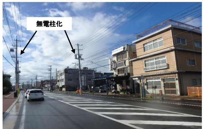
(都)外宮常盤線 (伊勢市) [緊急輸送道路の無電柱化に係る事業]
