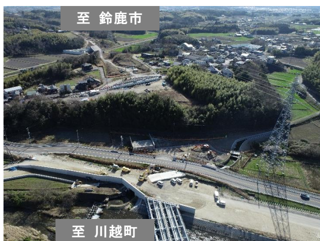
⑨北勢バイパス（四日市市西坂部町地内）
