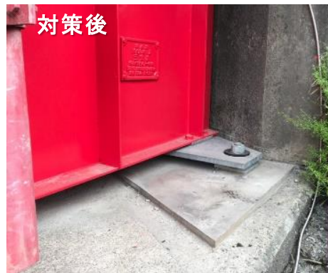
桁と支承の修繕を実施
