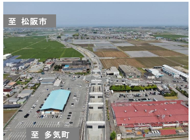
⑬松阪多気バイパス（松阪市上川町地内）
