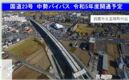
国道23号中勢バイパス整備箇所
