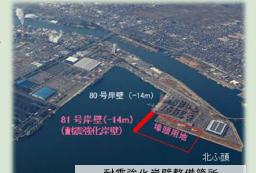
耐震強化岸壁整備箇所
