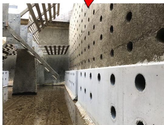
整流壁の耐震補強状況 (コンクリートの増し打ち)
