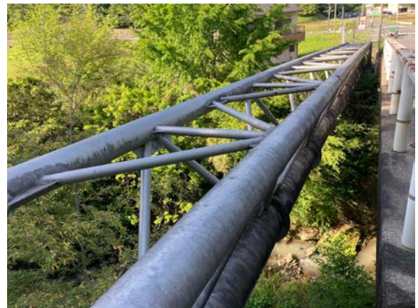
塗り替え予定の穴倉川水管橋
