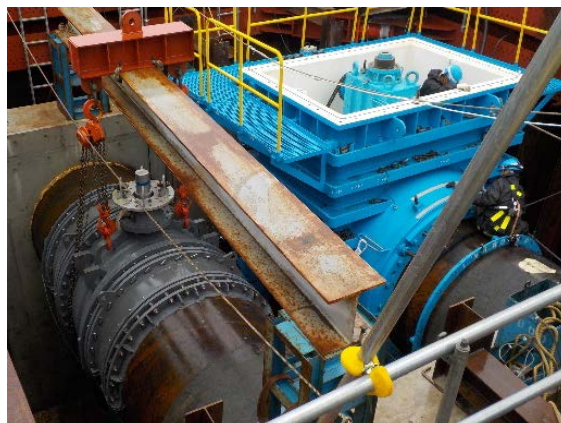
不断水工法*による制水弁設置状況
