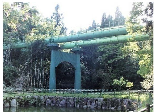
塗り替え予定の志知水管橋
