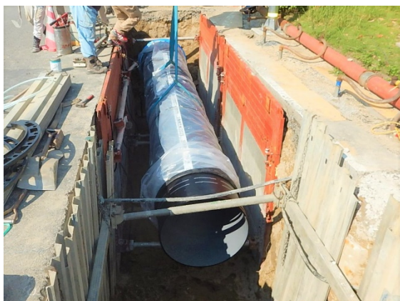
配水管布設替工事の施工状況
