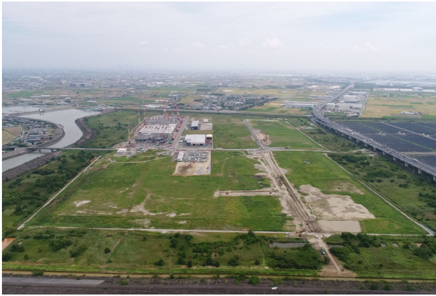
図 1-1 木曽岬新輪工業団地の現況 (木曽川上空より撮影、撮影日：令和 3 年 8 月 26 日)
