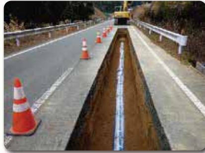
耐震管への布設替え
