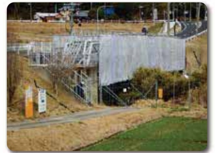
塗装塗替中の水管橋
