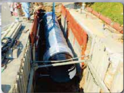
配水管布設替工事の施工状況
