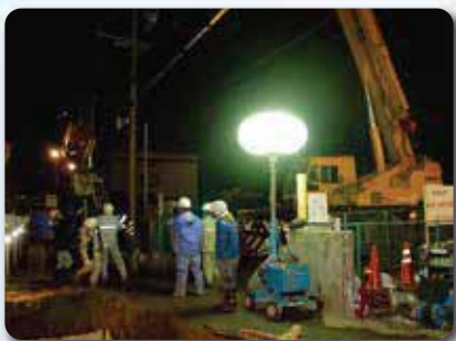
夜間の漏水復旧作業
