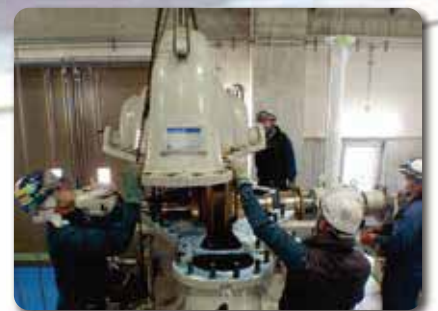
分解点検中のポンプ設備
