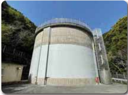
調整池の耐震補強
