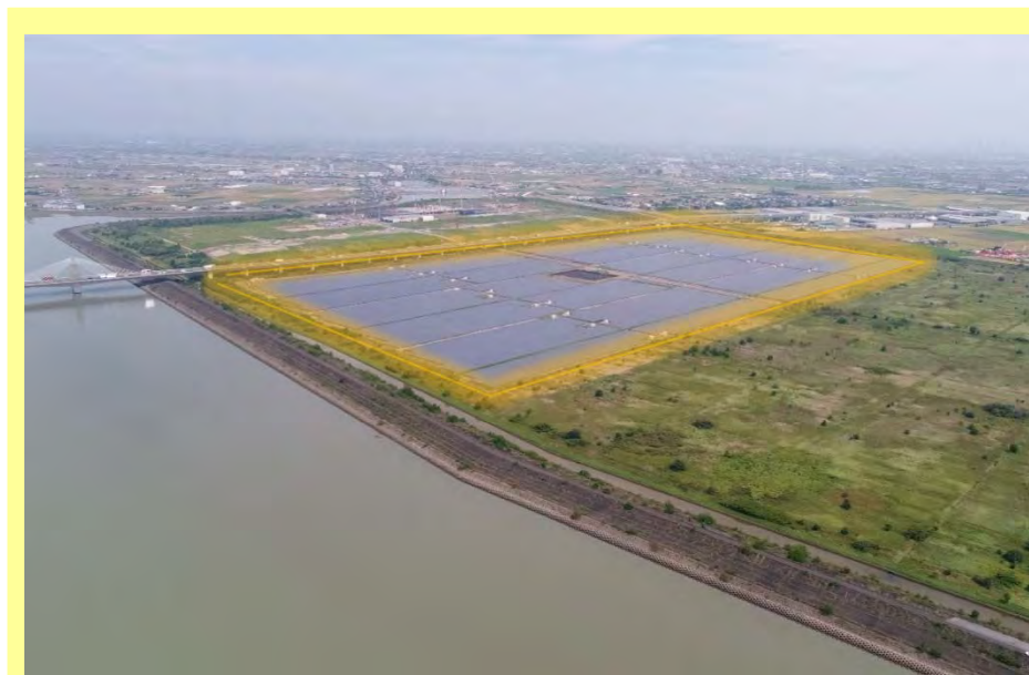
木曾岬干拓地メガソーラー発電所
