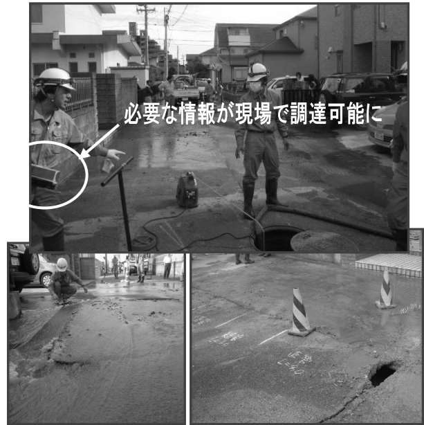
図-24 漏水事故現場での移動端末の活用
