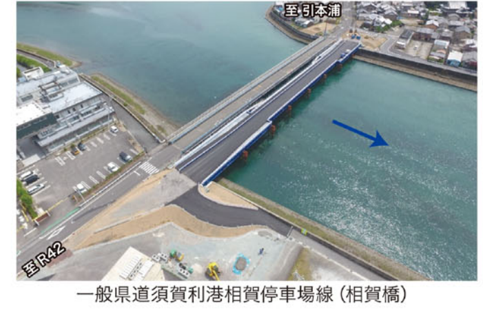
一般県道須賀利港相賀停車場線(相賀橋)
