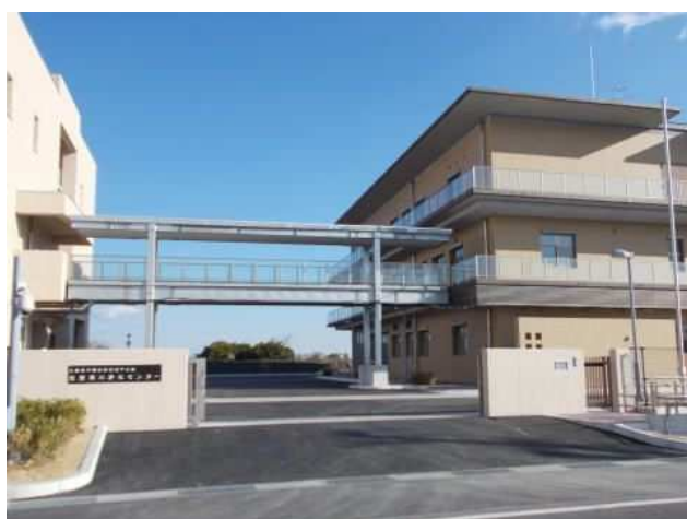
志登茂川浄化センター
