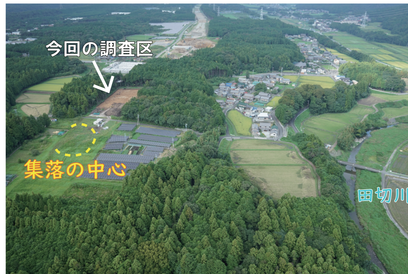
下平大野B遺跡の遠景(上空の南から)
