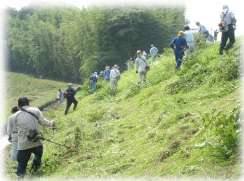
ため池法面の草刈り作業
