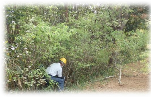
歩道沿い除伐状況
