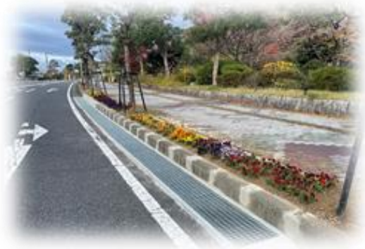
雨水浸透設備（県庁前）
