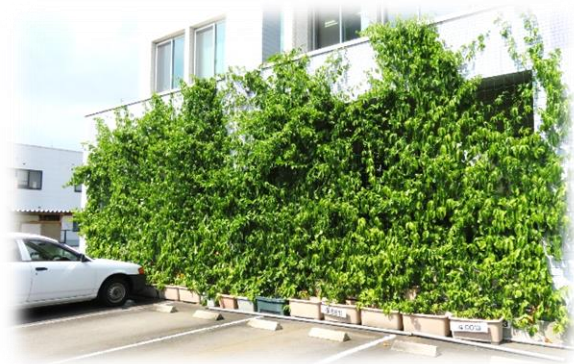
県桑名庁舎のグリーンウォール設置
