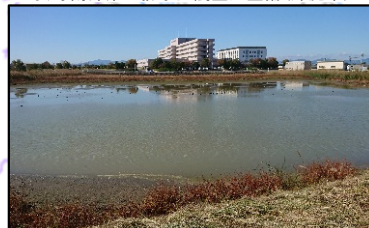
安塚南部第1排水区調整池整備(鈴鹿市)
