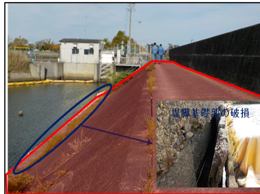
堀切川における堤防補強 （三重県）
