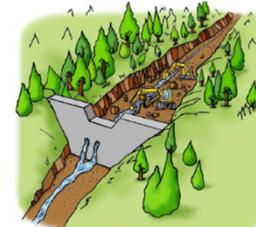
砂防堰堤堆積土砂撤去
