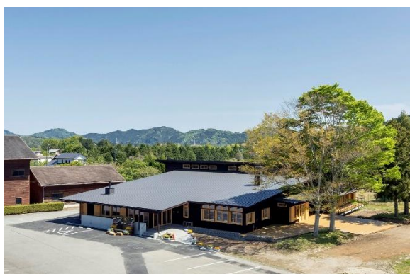
写真-1. みえ森林・林業アカデミー棟の全景
