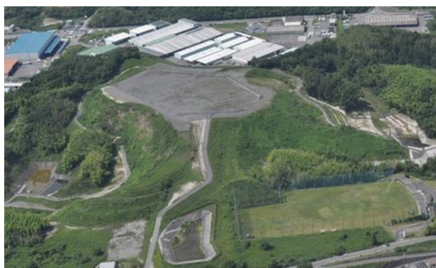
廃棄物埋立区域の覆土
