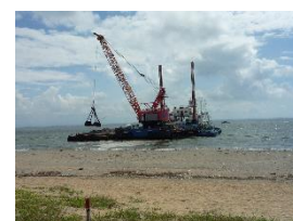
図6 堆積土砂を用いた干潟の造成
