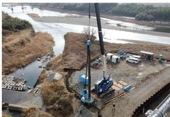
油の拡散を防止する鋼矢板の設置
