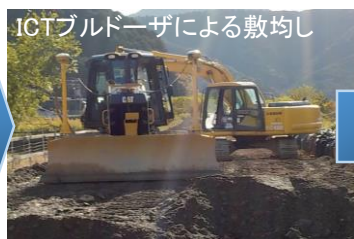
設計データにより施工を自動制御
