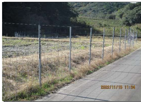
シカ対策としてイノシシ柵上段に 架線設置(R4.11)
