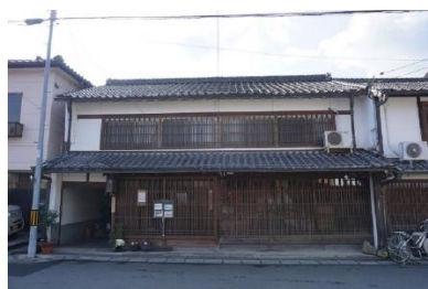
玄関棟外観（北から）
