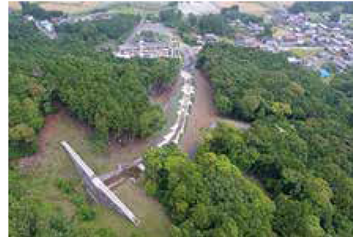
土砂災害防止施設の整備
