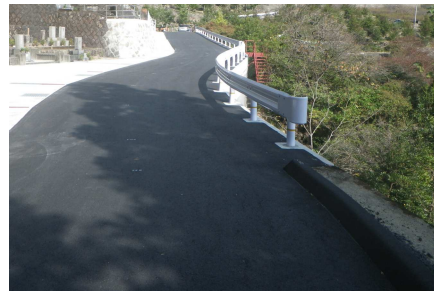
集落道 整備後
