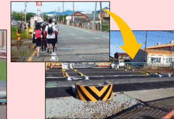
大淀、松阪第4号踏切（松阪市）
