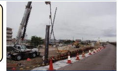
二級河川堀切川(鈴鹿市) (堤防耐震対策)
