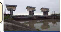
二級河川笹苗川(明和町) (水門耐震対策)
