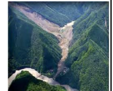
河道閉塞発生直後 (五條市大塔町赤谷地区)
