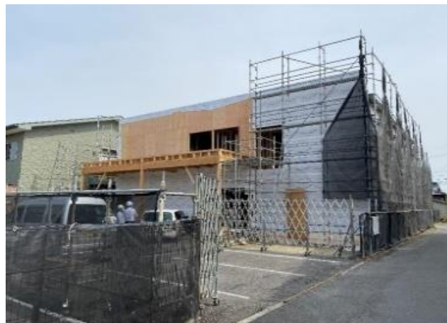
( 四日市営業所建築時外観 )
