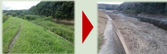
河川の堆積土砂撤去（榑原川（津市））
